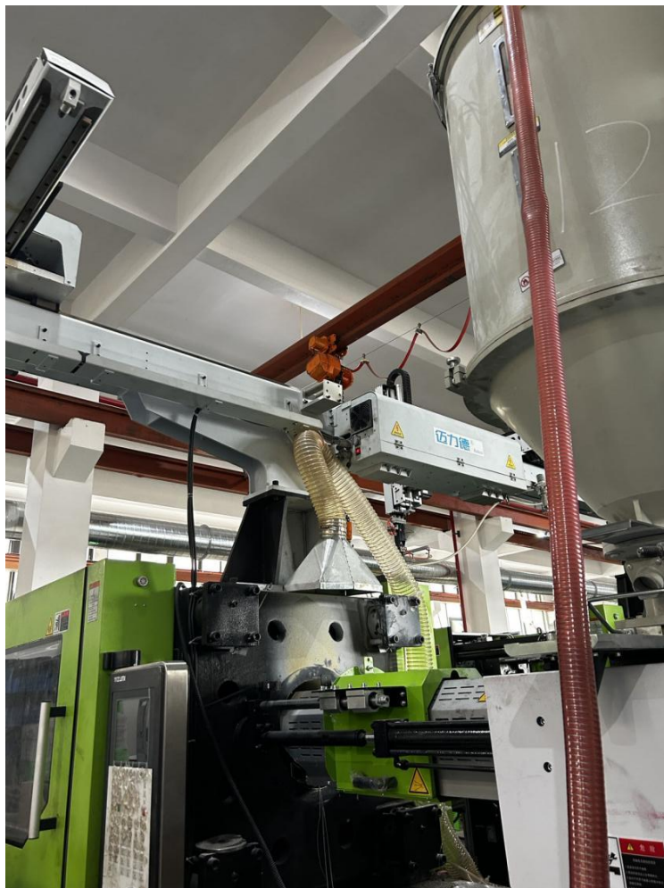
废气收集设施
